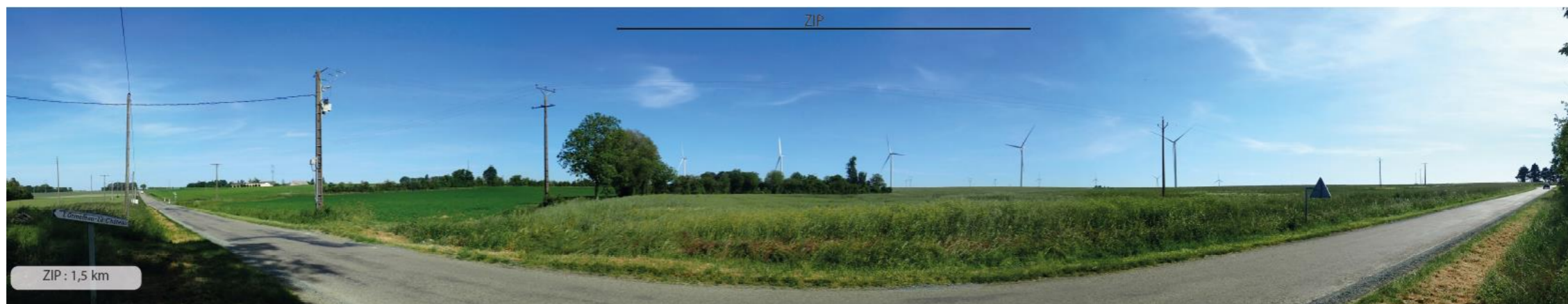
Photo 136 : P84 - Depuis la jonction de la voie d'accès à la commanderie et la RD 27, les vues sont ouvertes sur le parc éolien de Reuilly et de Diou et le VIP est partiellement filtré par la végétation en arrière-plan (© agence COUASNON)
