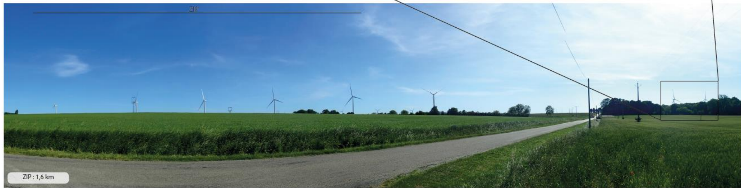
Photo 137 : P85 - Depuis la RD 27 en arrivant sur l'Ormeteau par l'est, les vues sont ouvertes sur le milieu agricole et le parc de Reuilly et de Diou ; le VIP prend place sur une large envergure sur la gauche tandis que l'on aperçoit les tours de la commanderie à travers la végétation sur la droite créant ainsi un risque de covisibilité indirecte (© agence COUASNON)
