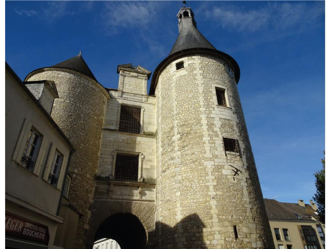
Photo 105 : P53 - Vue sur la porte dite «de l'Horloge» des fortifications d'Issoudun
