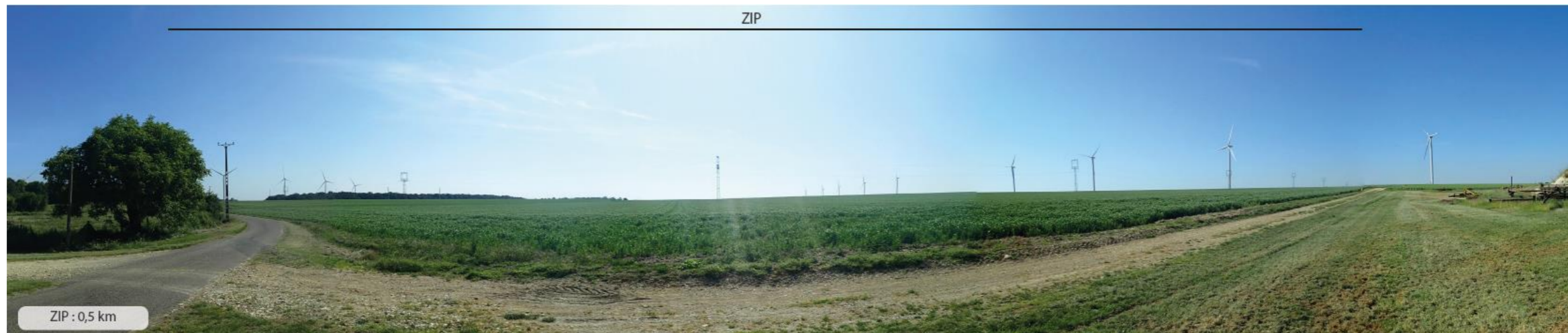
Photo 120 : P68 - Depuis ce point aux abords de la RD 65, à 500 m de la ZIP, le VIP est visible sur une large emprise horizontale avec une prégnance visuelle importante et se superpose en partie aux parcs existants de Reuilly, de Diou, des Pelures Blanches et d'Aubigeon
